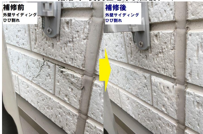
外壁サイディングひび割れ
